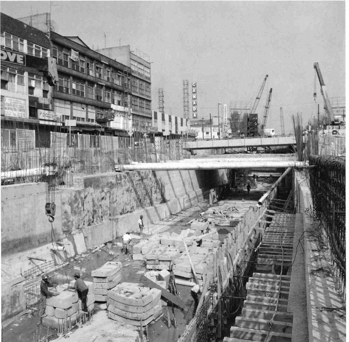
Construcción de la estación Obrera sobre el Eje Central.
